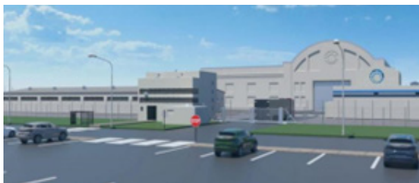
赫尔墨斯低功率示范堆核电厂概貌
