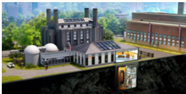
伊利诺伊大学厄巴纳-香槟分校校园内超安全核能公司（USNC）微型模块化反应堆（MMR）核电厂概貌。
