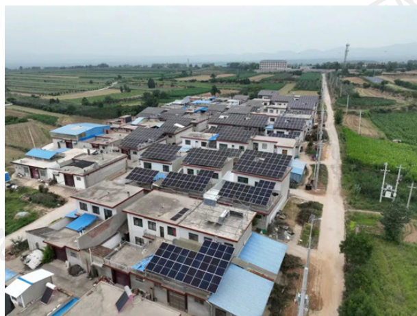
铜川市耀州区光伏项目
